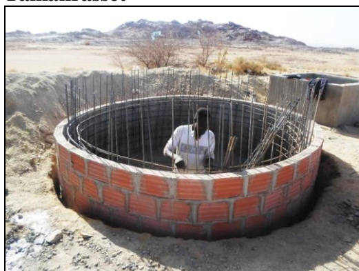
Figure 5 étapes de la construction du biodigesteur de 15m 3 de Tamanrasset
